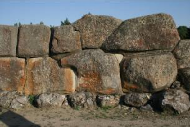
Sur duvarlarında taşların örülme şekli.
