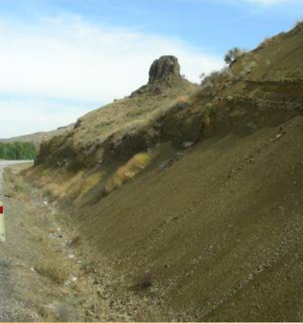
Eosen flişinde oturma (slump) yapıları.
